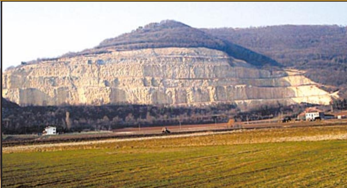
**Coltivazione a regola d'arte nella cava di Sossano, presso Vicenza, per quanto riguarda il contenimento dell'impatto sismico. La progettazione del brillamento delle volate entro valori di sicurezza e di tollerabilità per i manufatti edili e per il corpo umano, grazie al monitoraggio sismico continuativo**
